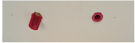
Bild 7: Mit Kunststoffhalbschalen können große Durchführungslöcher nachträglich etwas abgedichtet werden.
