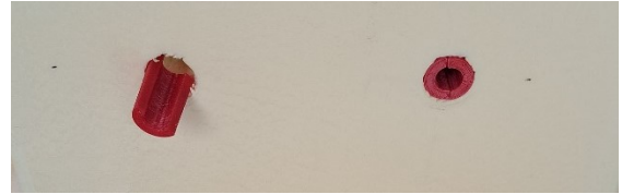
Bild 7: Mit Kunststoffhalbschalen können zu große Durchführungs Löcher nachträglich etwas abgedichtet werden.
