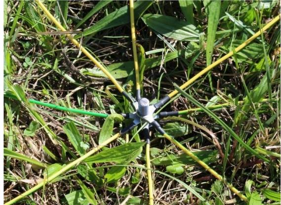
*Bild 13: Der Erdspieß wird in den Boden geschlagen und auf einer Mutter die Radials eingehängt und ausgelegt*
