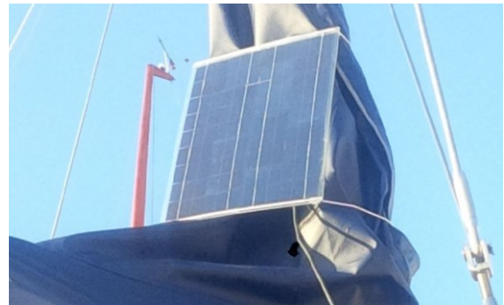
Bild 4: Montage des Solarmoduls auf dem Boot im Winterlager
